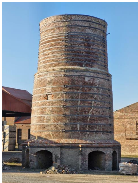
Le four à chaux entièrement restauré
