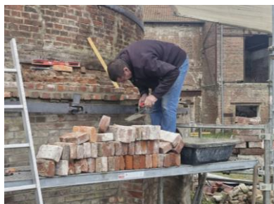
La réparation de la couronne du four par l'entreprise Bachelet Frères
