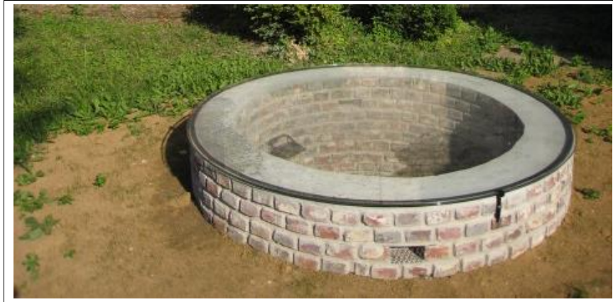
Puits originel de la Sucrierie restauré en mai-juin 2019
